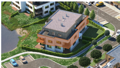
Situácia v rámci zástavby
